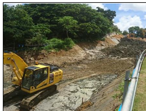
宜野湾市道11号 支障除去措置(不発弾探査) 実施状況
